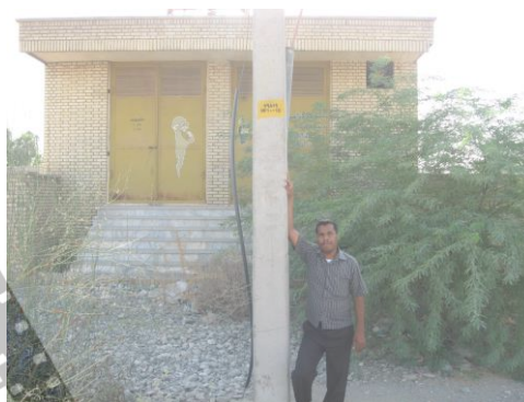
تصویری از درج کد تیر با ارتفاع ۲/۵ متر از سطح زمین
